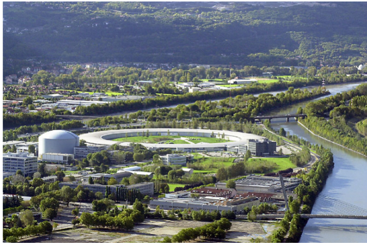
Abbildung 1.1: Das Institut Laue-Langevin (ILL) in Grenoble, zwischen der Drac und der Isère gelegen. Das Experiment wurde in der Reaktorhalle am linken Bildrand durchgeführt.
