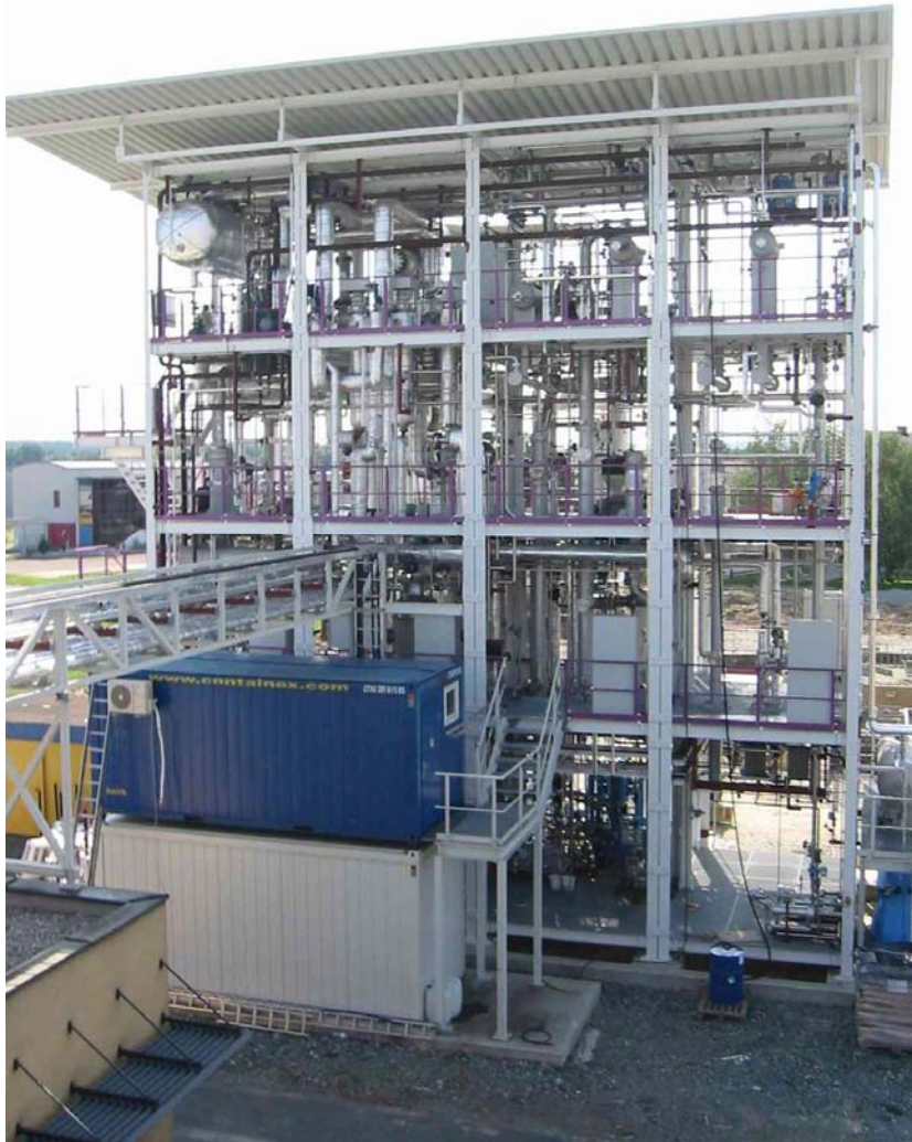
Abb. 2: Demonstrationsanlage zur katalytischen Aufbereitung von Holzgas zu synthetischem Erdgas am Standort Güssing.
