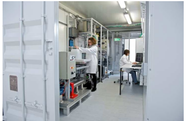
Blick in den Container: Links vorne ist die Hochdruck-Förderpumpe zu erkennen; Links hinten im Käfig befindet sich die Hochdruckanlage. Quelle: PSI
