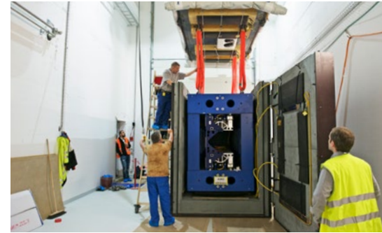
Das SwissFEL-Undulatorgestell wird aus dem Container gehoben. Insgesamt zwölf Stunden dauert der Transport in das SwissFEL-Gebäude und die Platzierung vor Ort.
