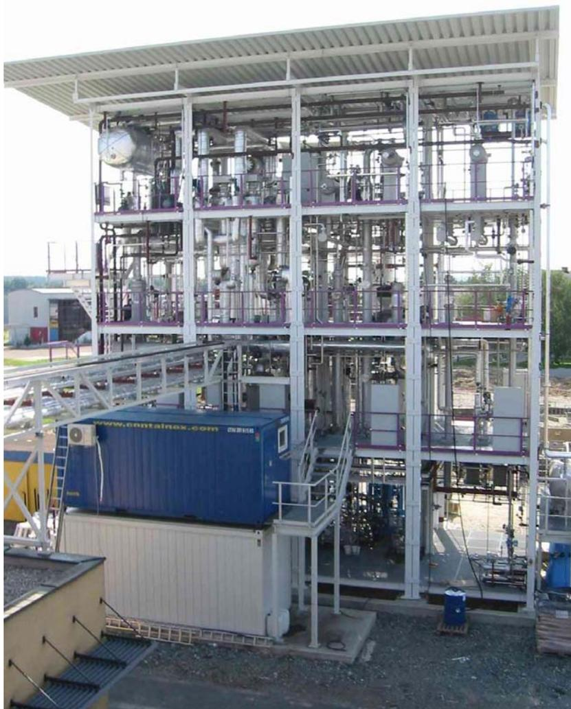
Fig. 2: Installation de démonstration pour la préparation catalytique du gaz de bois en gaz naturel de synthèse, sur le site de Güssing.
