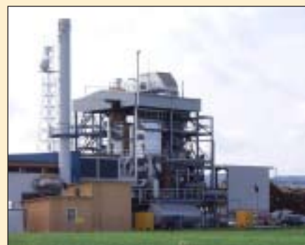
Centrale de biomasse de Güssing (Burgenland, Autriche).
