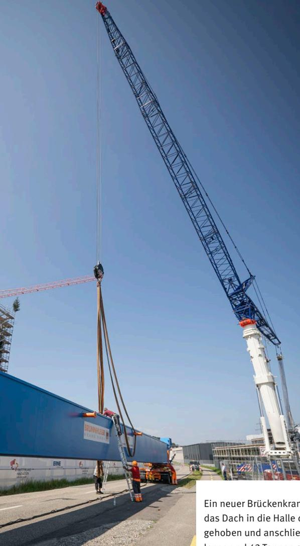
Ein neuer Brückenkran wurde mithilfe von Baukränen durch das Dach in die Halle der Synchrotron Lichtquelle Schweiz SLS gehoben und anschliessend dort installiert. Das 42 Meter lange und 42 Tonnen schwere Gerät wird dabei helfen, das Upgrade zur SLS 2.0 zügig voranzutreiben.
