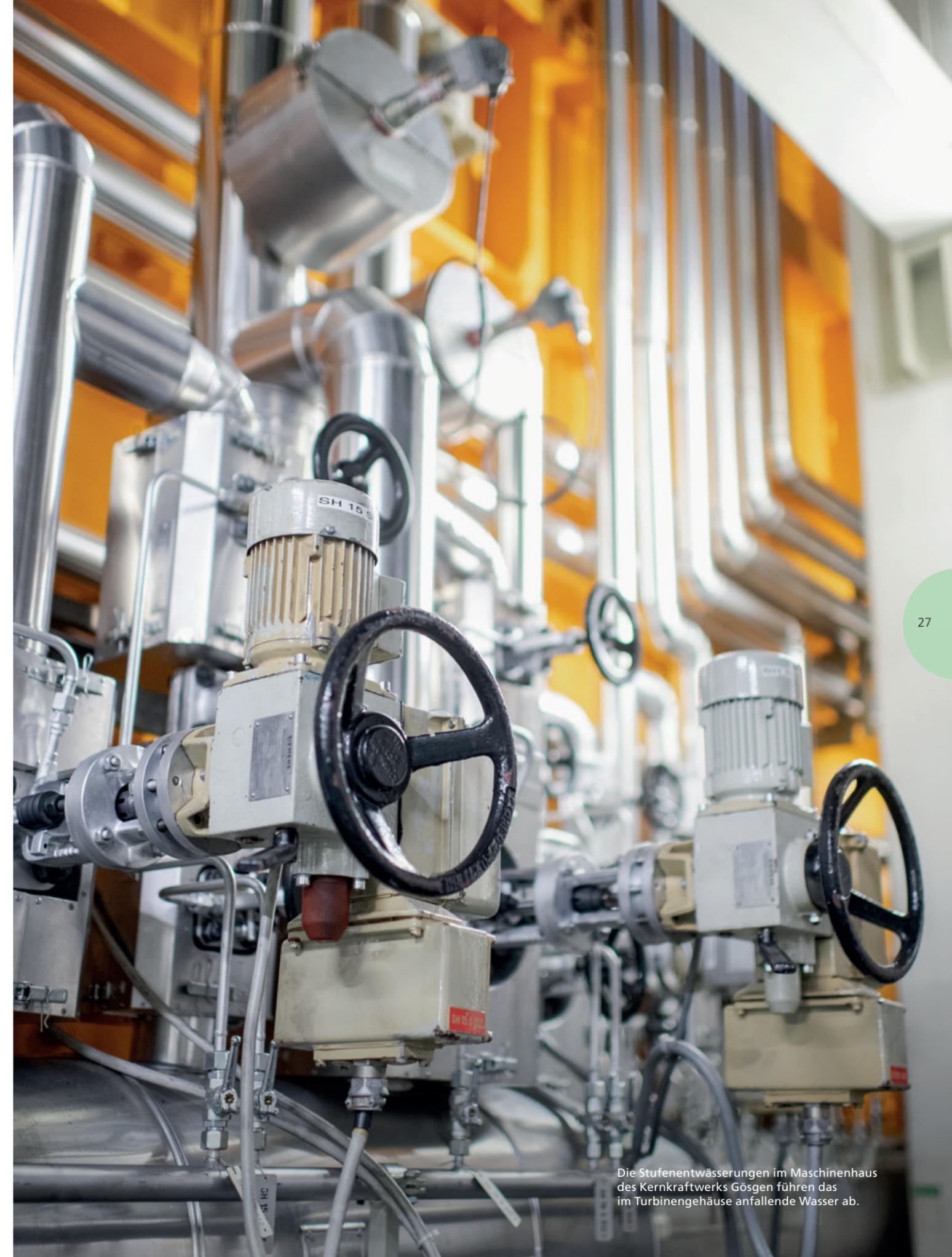
Die Stufenentwässerungen im Maschinenhaus des Kernkraftwerks Gösgen führen das im Turbinengehäuse anfallende Wasser ab.
