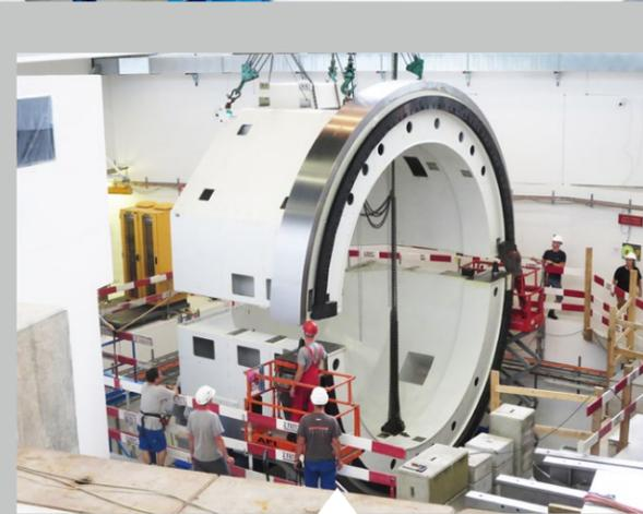
Die Montage des oberen Ringes erfolgt. Schlussendlich wird die 270 Tonnen schwere Gantry 3 um 360 Grad drehbar sein.
