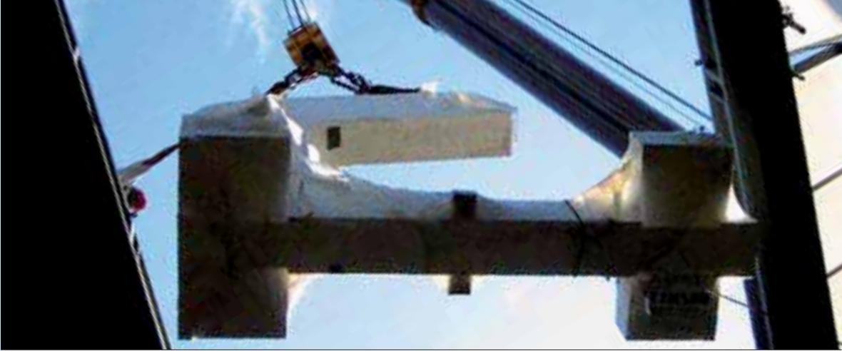
Das 32 Tonnen schwere Auflager der Gantry wird sorgfältig durchs Dach in die Nukleonenhalle abgesenkt.
