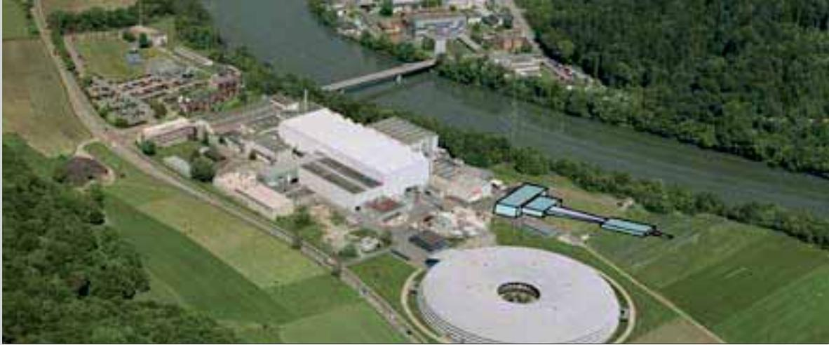
Der 800 Meter lange Freie-Elektronen-Laser X-FEL im PSI-Westareal soll teilweise unterirdisch verlaufen.
