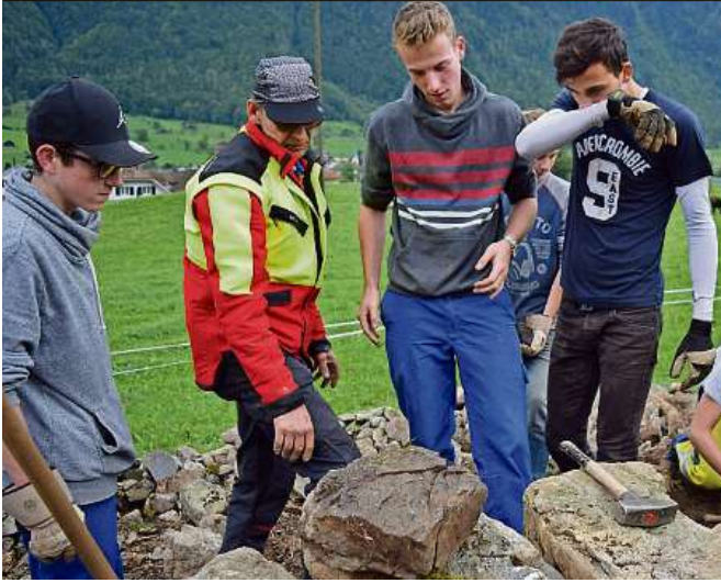
Lagebesprechung: Köbi Rast (Zweiter von links) zeigt den Jungs, wie sie den Stein am besten in die Trockenmauer setzen.
