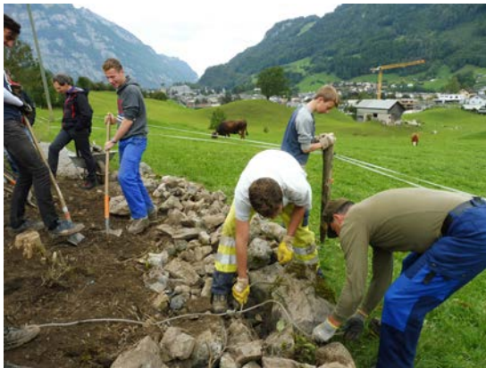
Unter fachkundiger Anleitung sanieren die Lernenden des PSI eine Trockenmauer.
