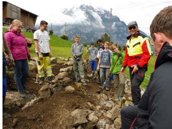
Unter fachkundiger Anleitung sanieren die Lernenden des PSI eine Trockenmauer.
