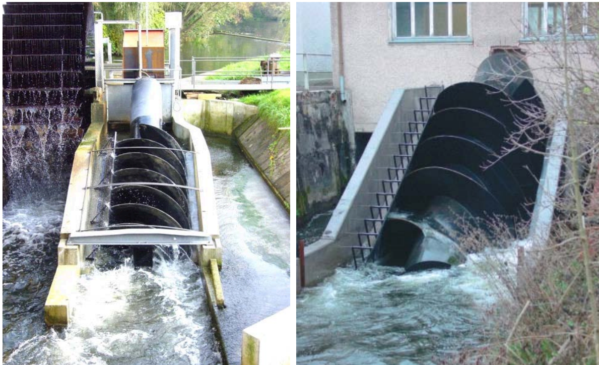
Fig. 4.4 Wasserkraftschnecken: 8.5 kW und 65 kW. d
